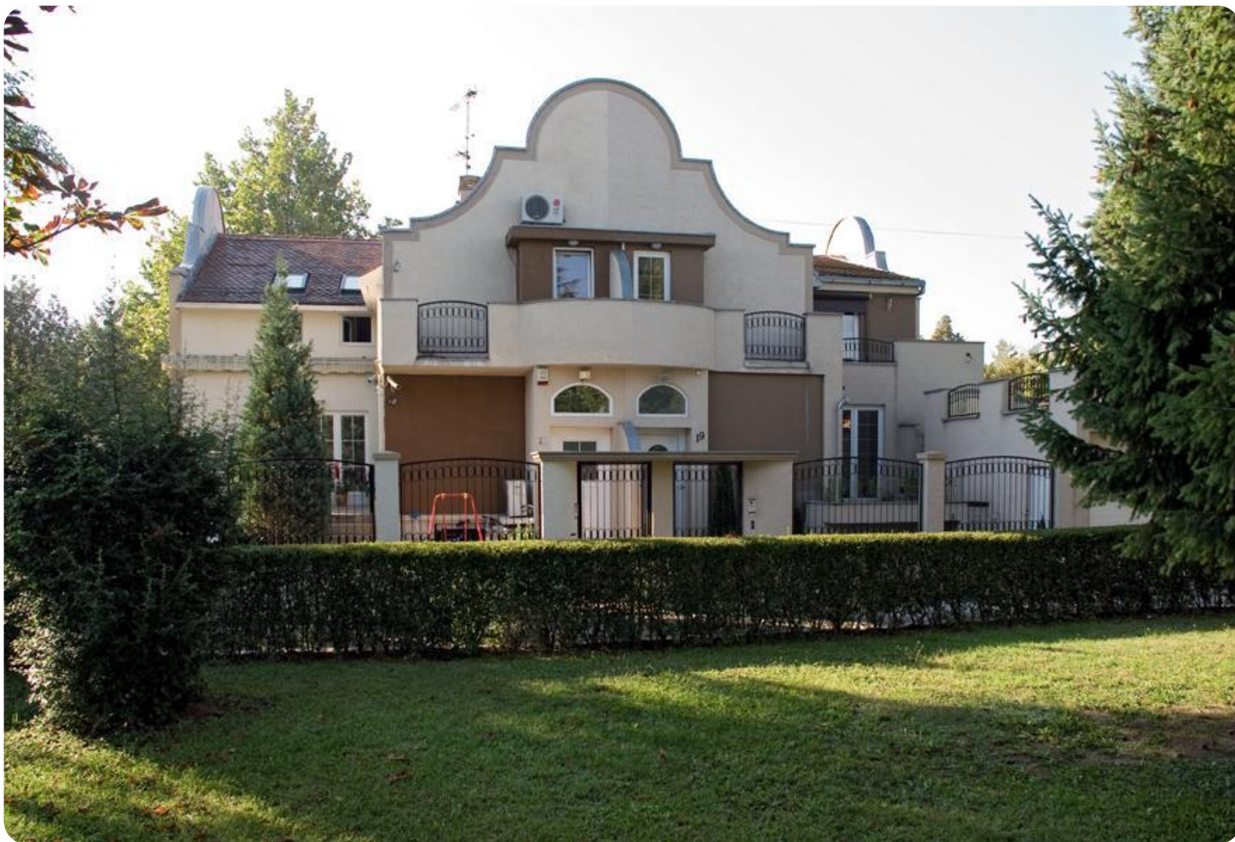
Roditeljska kuća Bežanijska kosa, Beograd
